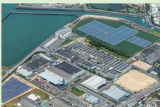
Kinuura Plant (Substrate Holding Mat)
