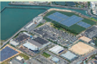
Kinuura Plant (Substrate Holding Mat)
